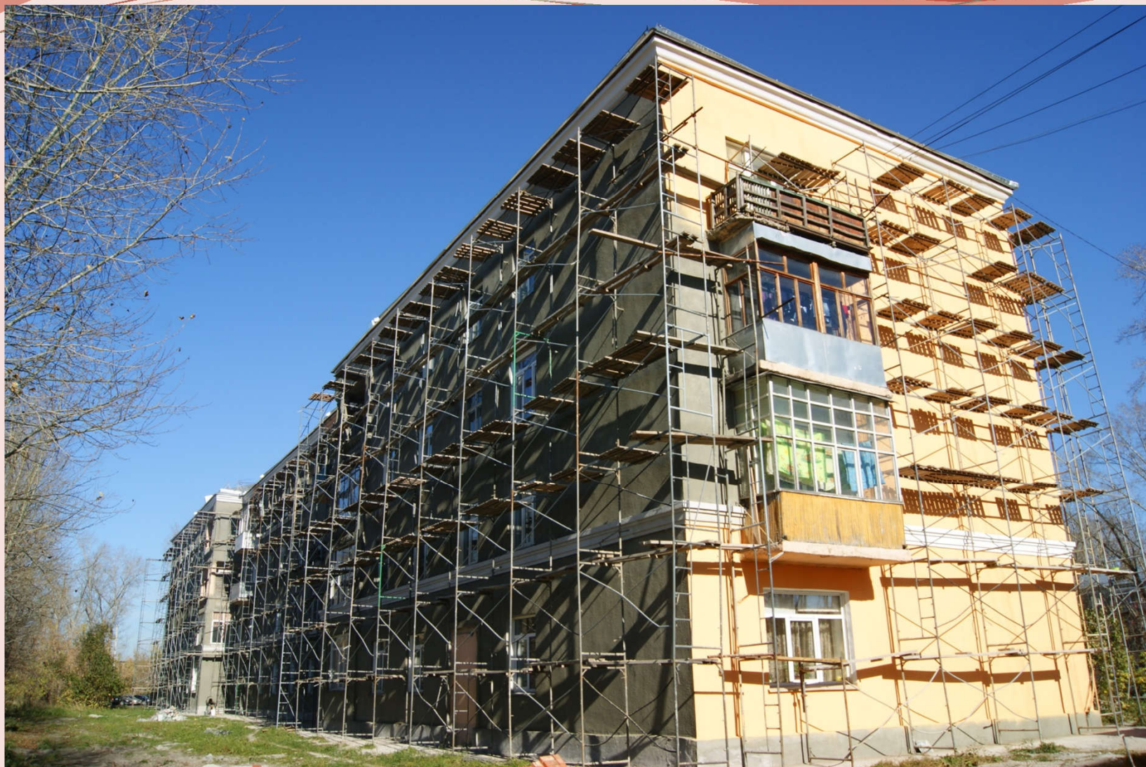
Капитальный ремонт 4-х этажного жилого дома № 103 Военного городка, 06.10.2018
