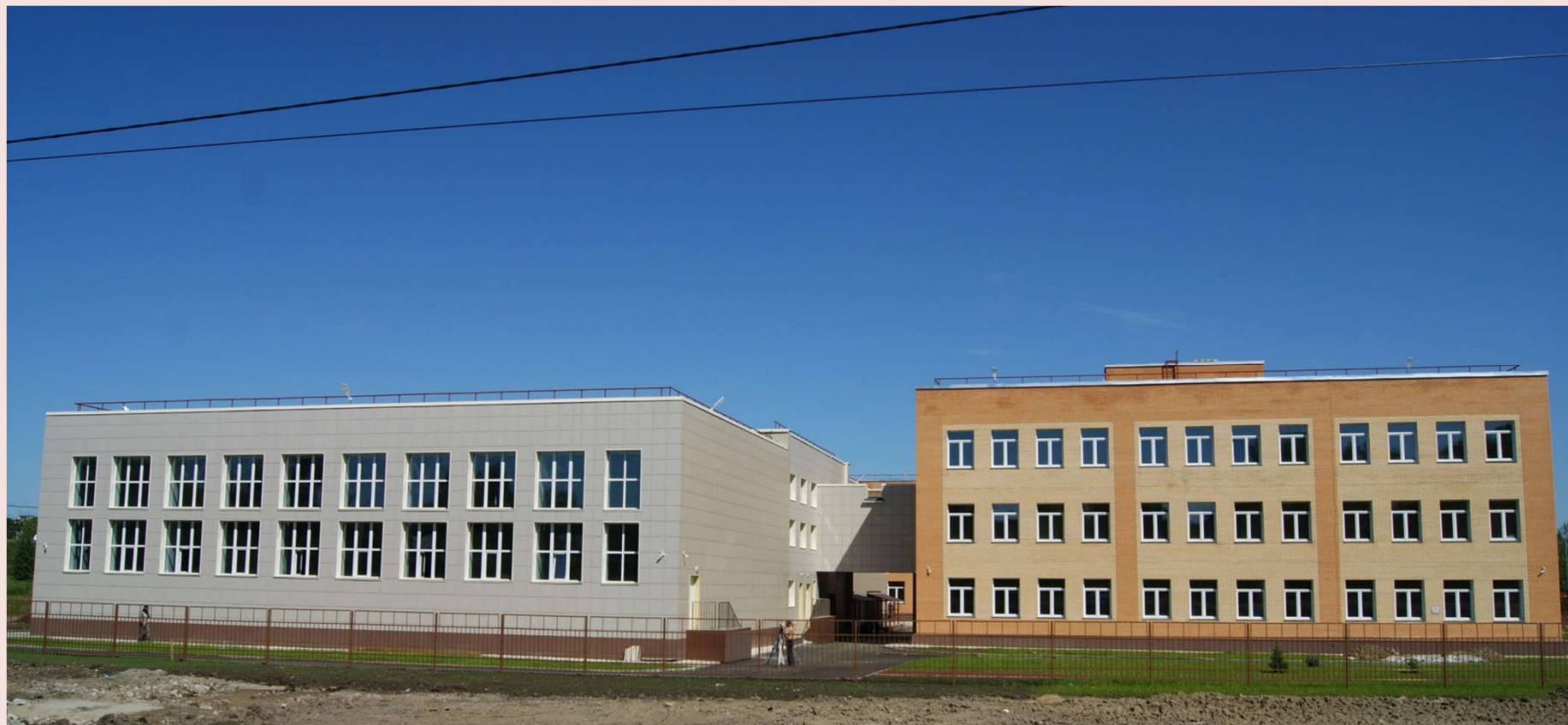
Строительство школы на 825 мест по улице Геодезической, 07.07.2018
