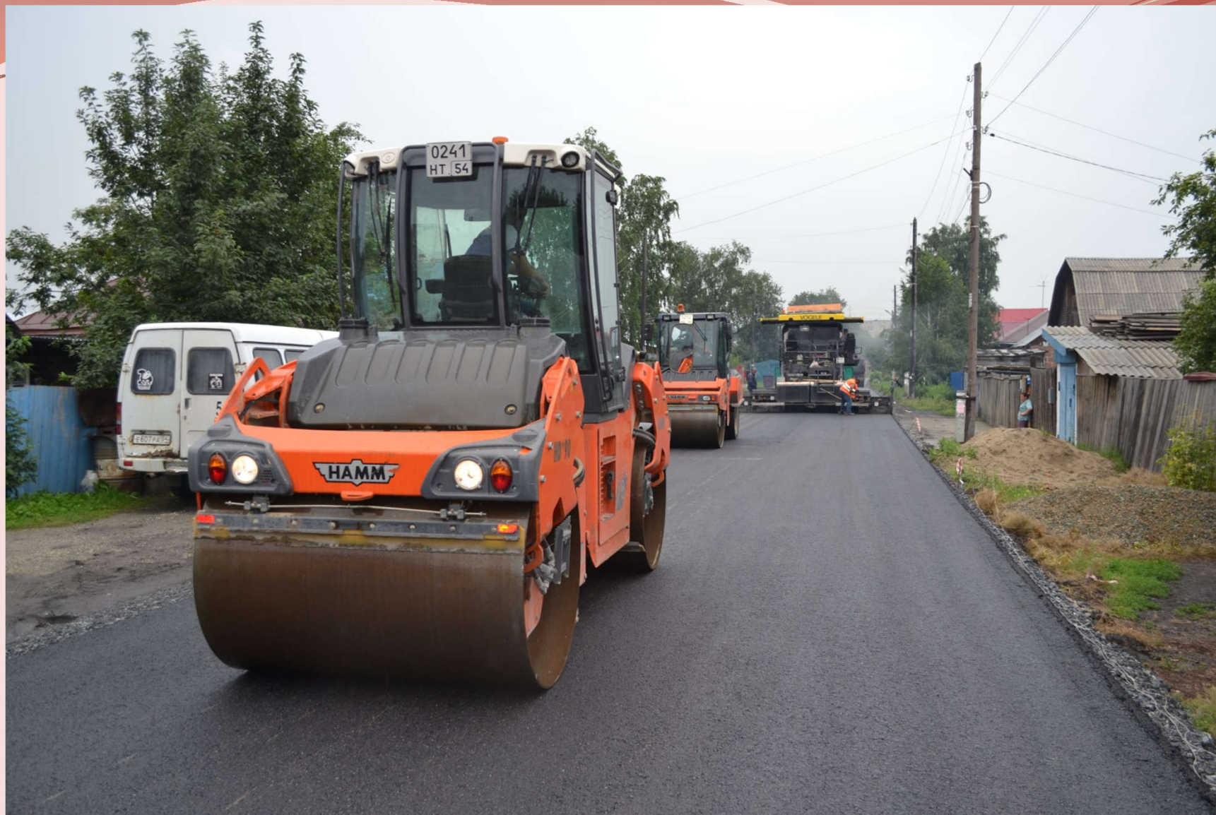
Капитальный ремонт (асфальтирование) улицы Покрышкина, 19.07.2016
