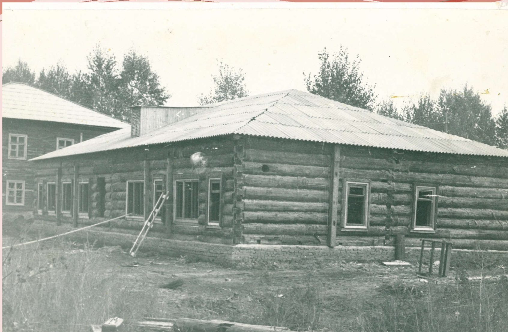
Строительство деревянного здания Детской музыкальной школы по ул. О.Кошевого, 1975 год
