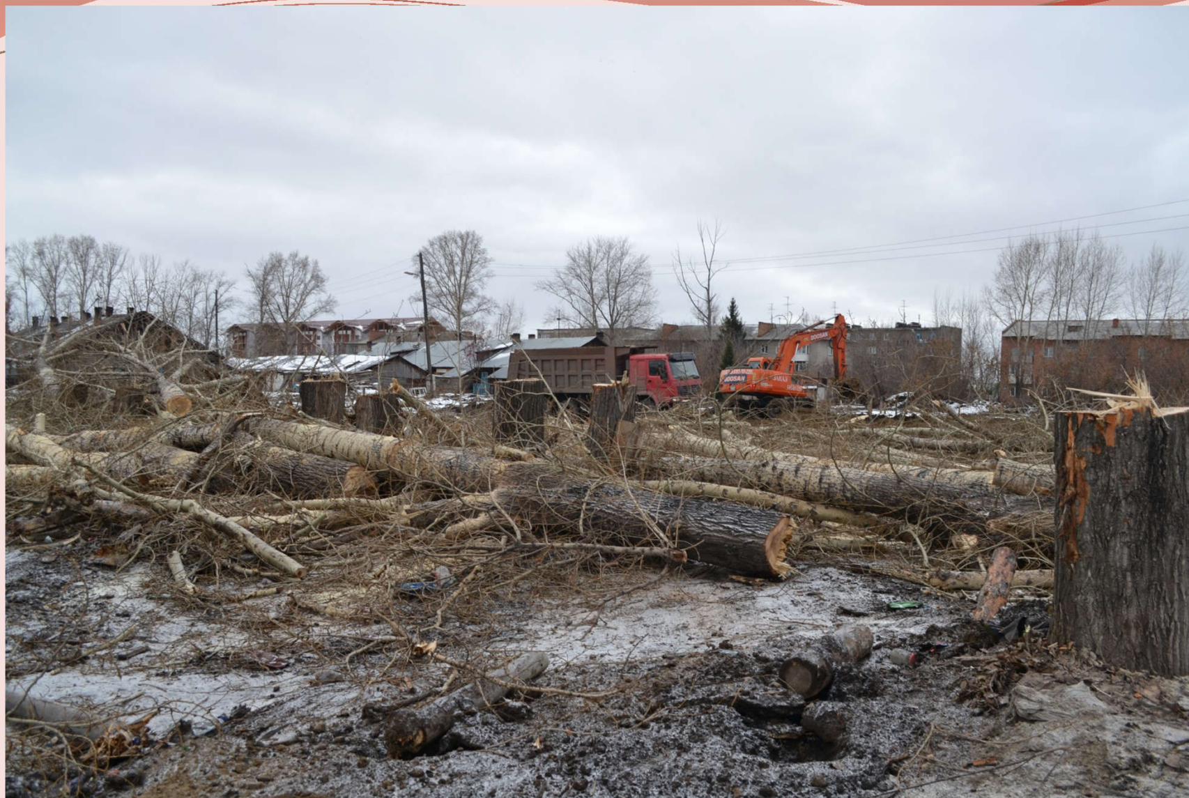
Подготовка строительной площадки для строительства детского сада на 230 мест по улице Шевченко, 17.10.2013
