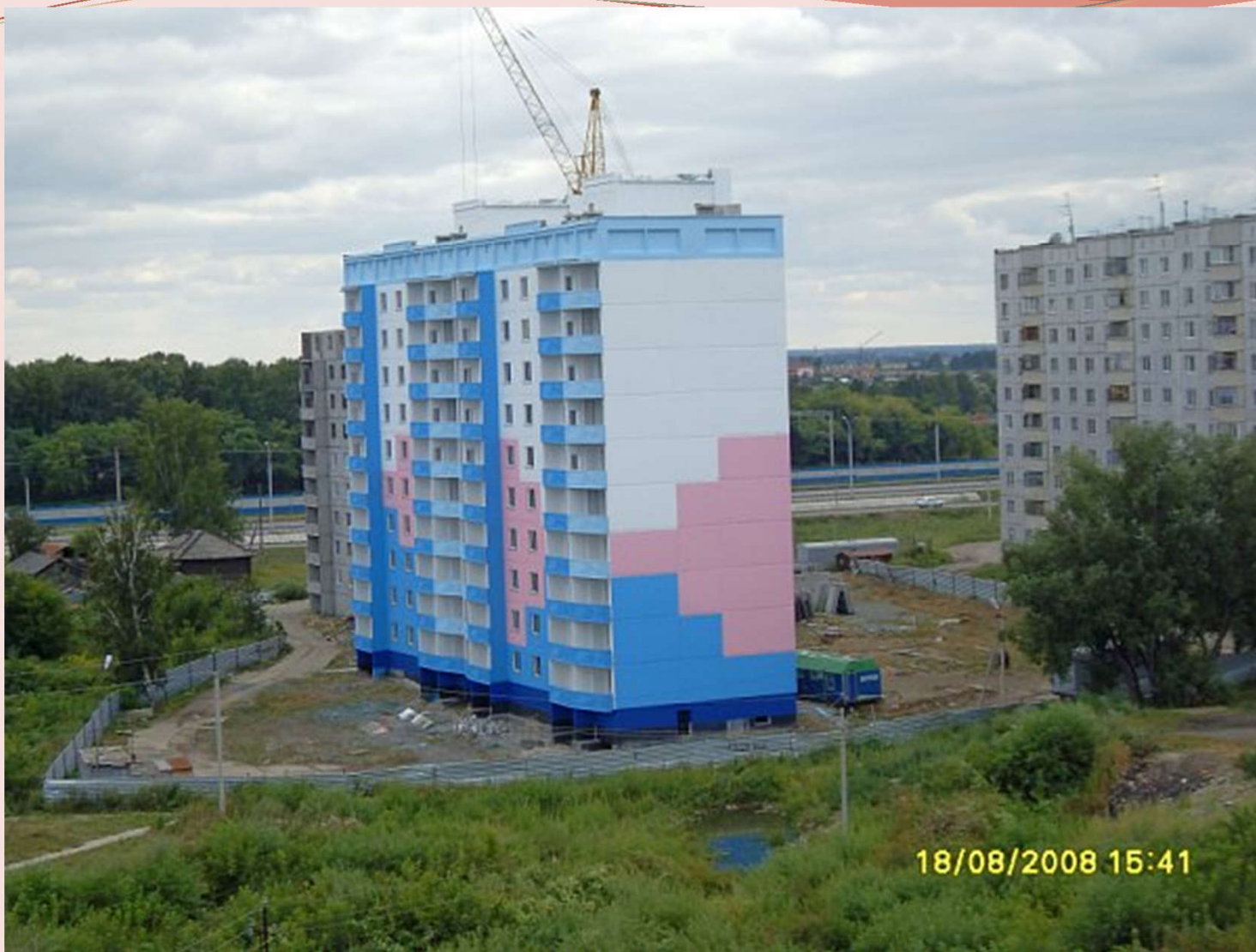
Строительство 10-ти этажного панельного дома по улица Чкалова, 18.08.2008
